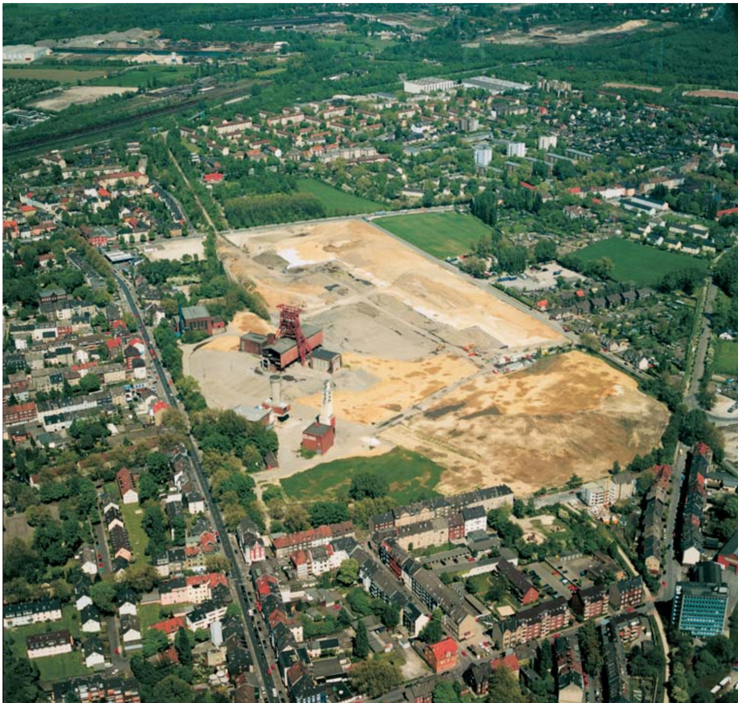
Schrägluftbild des abgeräumten Zechengeländes Consolidation Bildquelle: Stadt Gelsenkirchen, Amt für Stadtentwicklung und Wirtschaftsförderung
