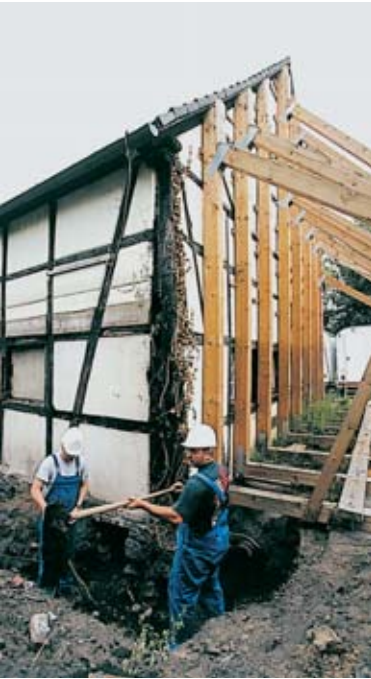
Umbaumaßnahmen am Alten Stall des Lahrshofs Bildquelle: Stadtteilbüro Bismarck/Schalke-Nord
